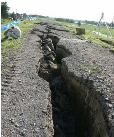
【被災後の鳴瀬川堤防】
