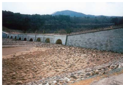
【完成した大暗渠堰堤】
