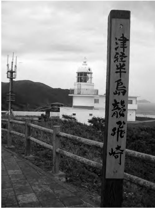
写真：竜飛崎灯台
