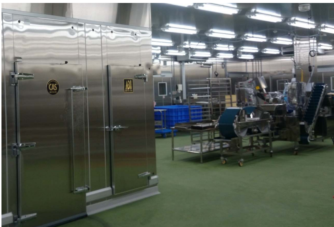
図 65 石巻水産加工施設の最新冷凍機（2）
