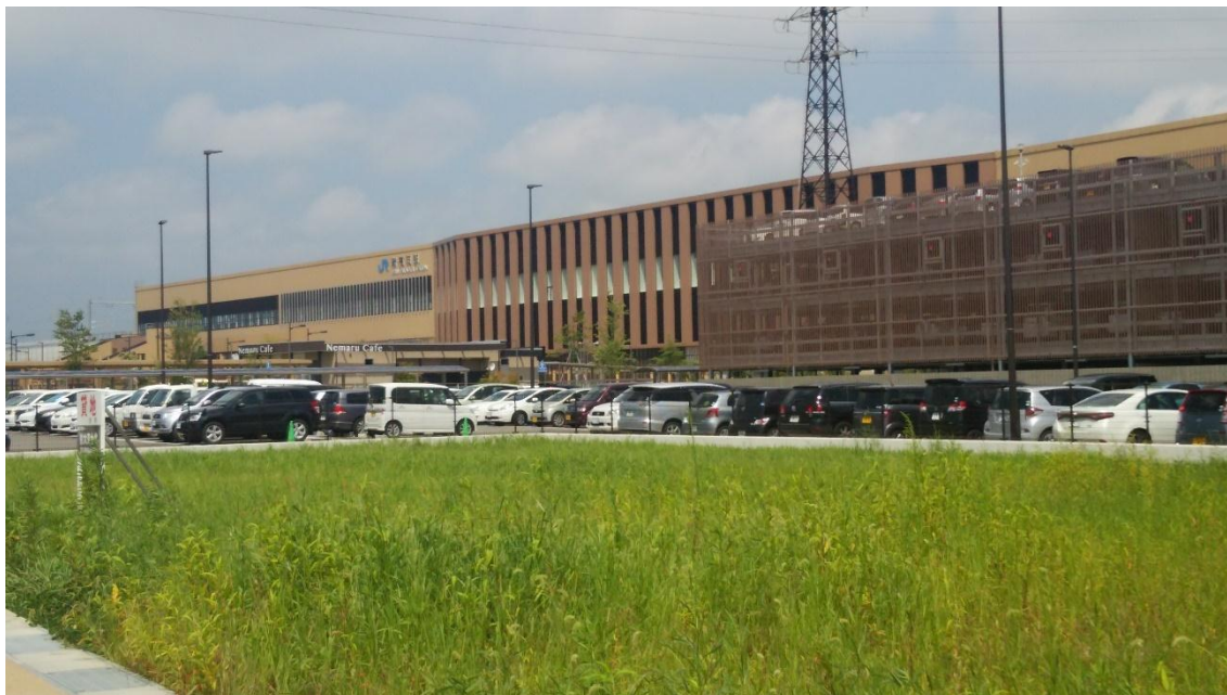
写真2 新高岡駅駅前駐車場
