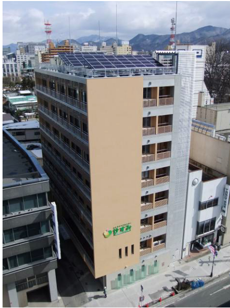
建物外観・発電装置
