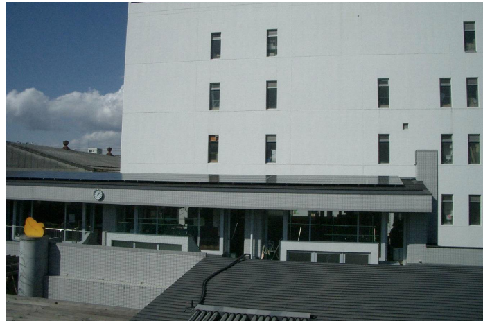
建物外観・発電装置
