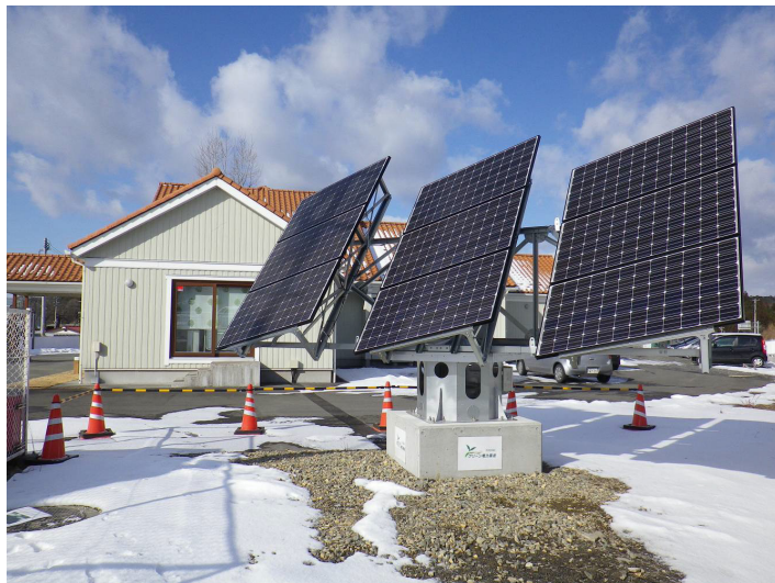
建物外観・発電装置
