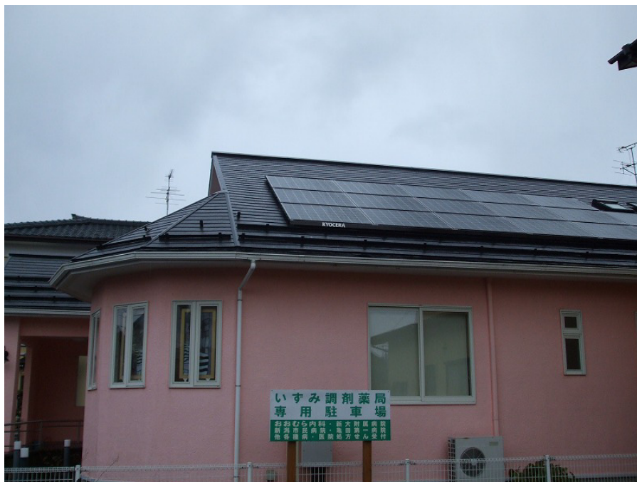
建物外観・発電装置
