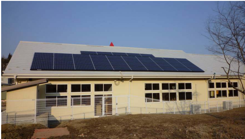
建物外観・発電装置
