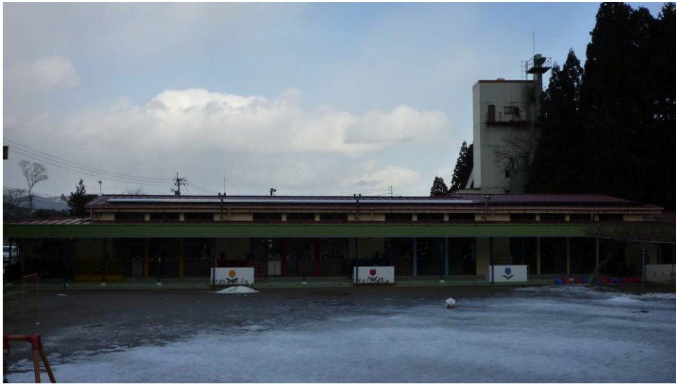
発電装置・建物外観
