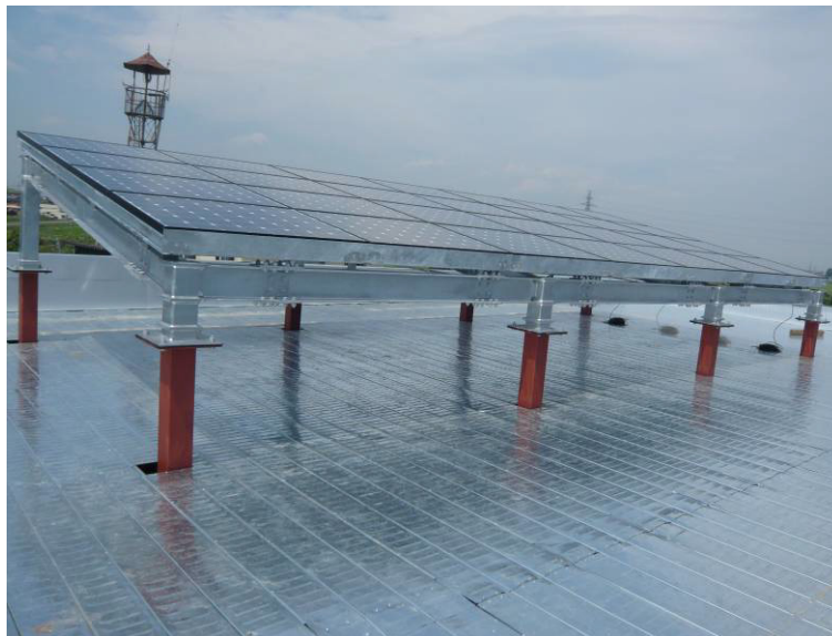
建物外観・発電装置
