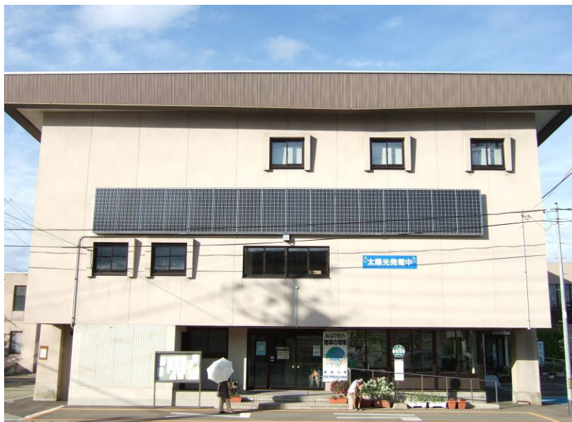
建物外観・発電装置
