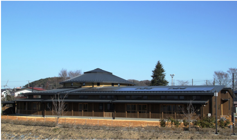
建物外観・発電装置
