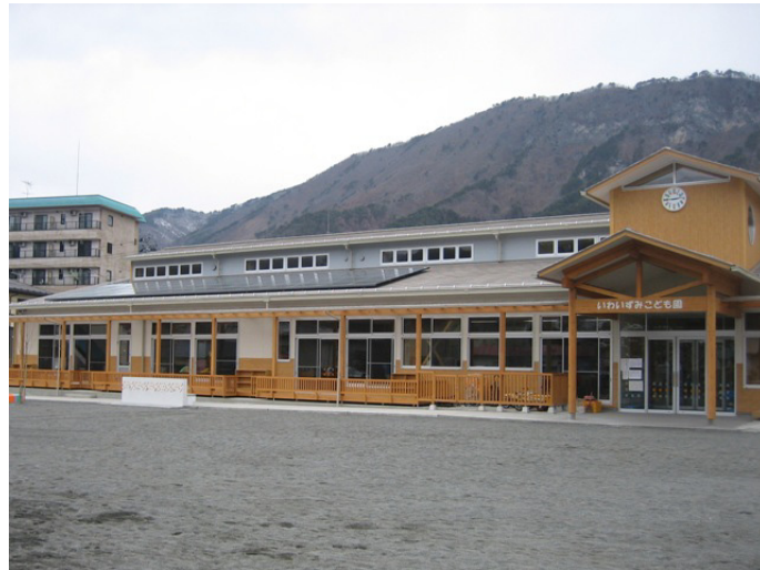
建物外観・発電装置
