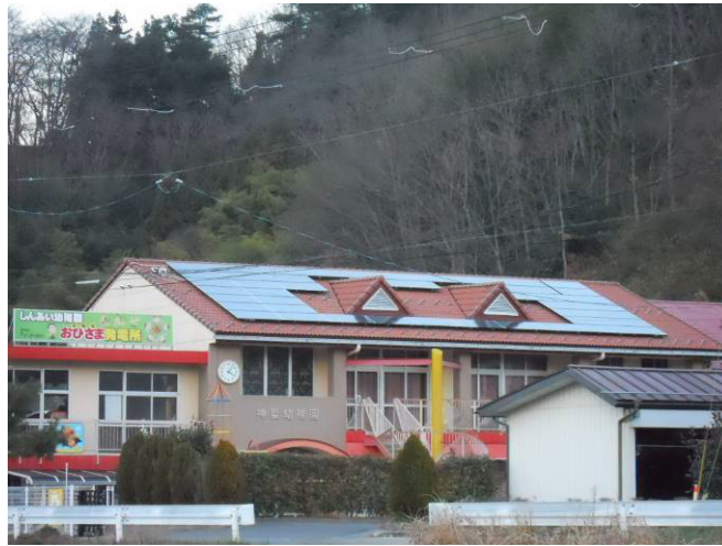
建物外観・発電装置
