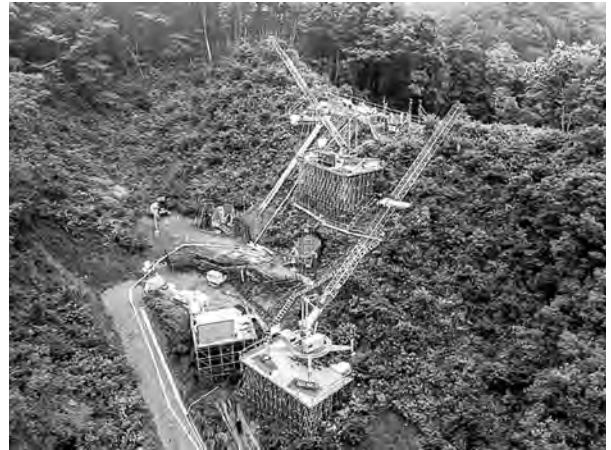
出羽マルチアングル工法ステージ敷設
