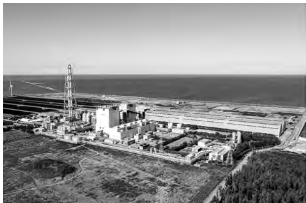
酒田共同火力発電所
