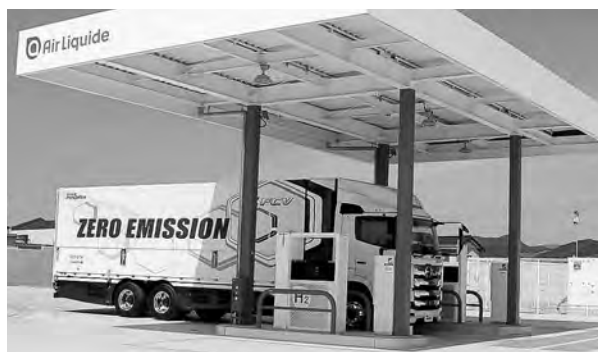
水素ステーション (本宮市)
