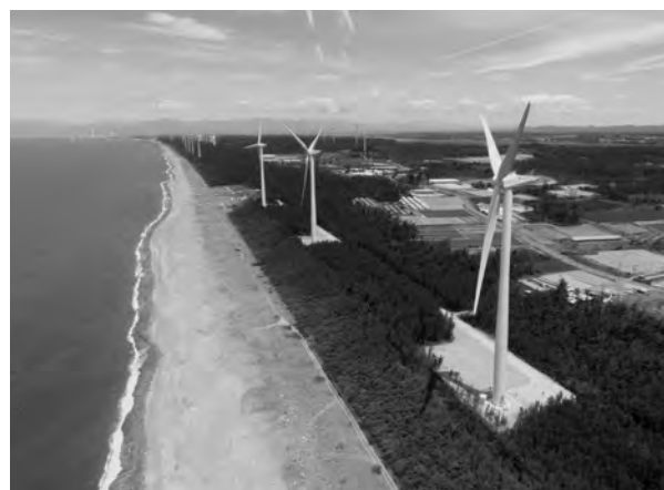
大林組の陸上風力発電第一号 三種浜田風力発電所（秋田県）
