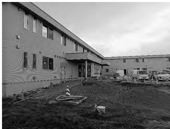
図表 17 建設中の学生寮
