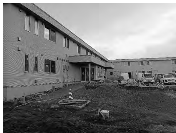
図表 17 建設中の学生寮
