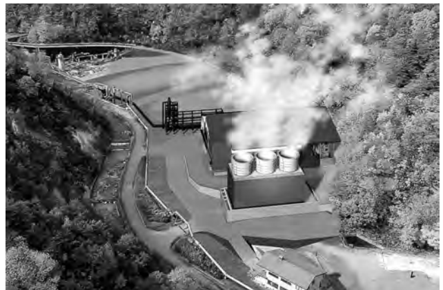
松川地熱発電所将来図 (現在リプレイス工事中、令和7年10月運開予定)
