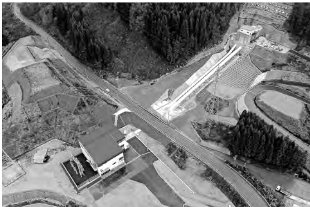
玉川第二発電所 (令和4年11月運開)
