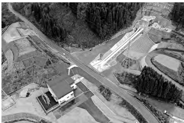
玉川第二発電所 (令和4年11月運開)
