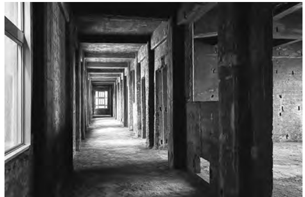
before : 廃虚化した旧第一小学校
