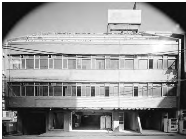
before : 東日本橋の空き物件
