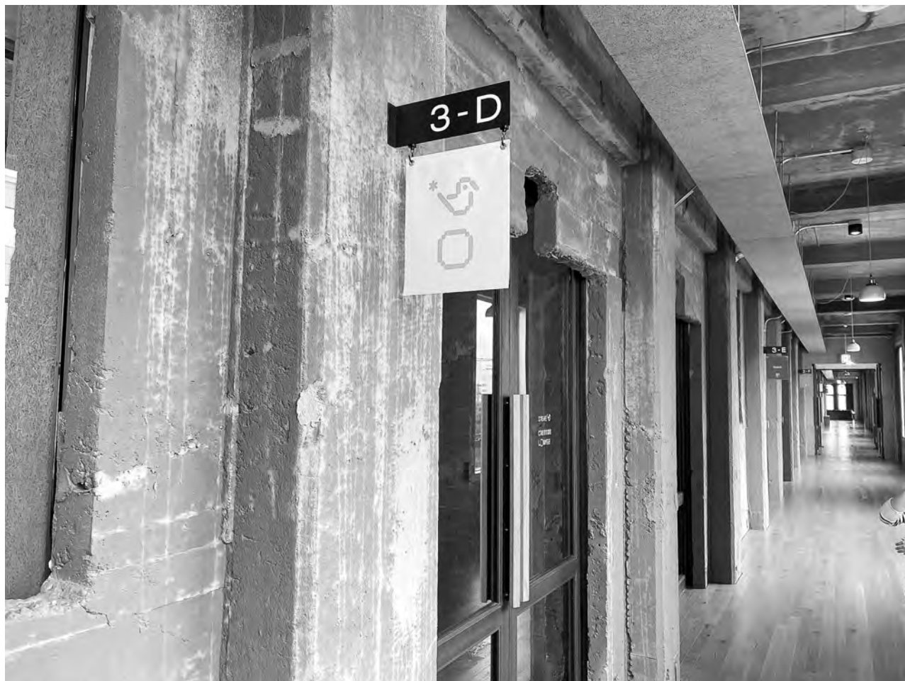
図表11 廊下の様子
