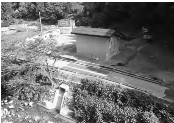
小水力発電 (上：取水部および堰堤周辺、下：発電所建屋)
