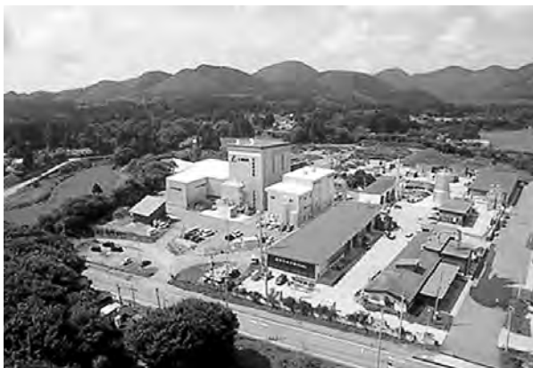
発電所上空より (株)タケエイ提供
