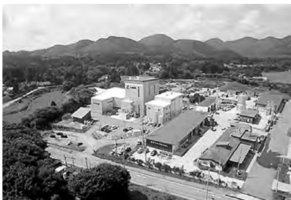
発電所上空より(株)タケエイ提供)
