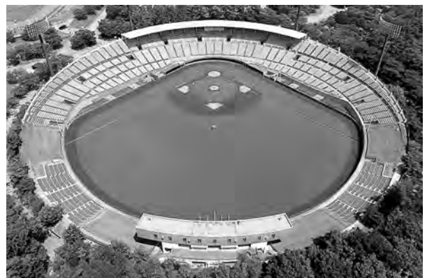
(人工芝への改修が完了した県営あづま球場)
