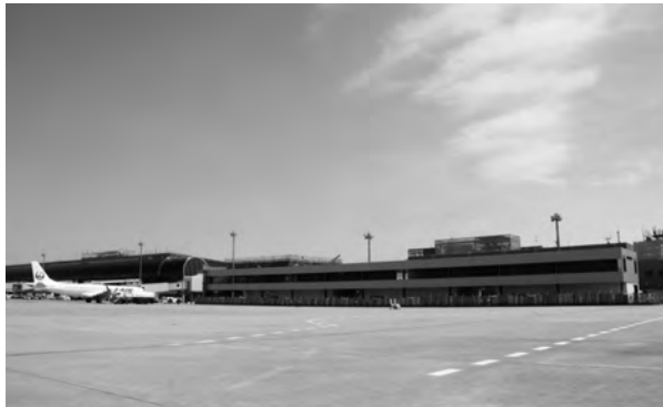
(写真3) 工事中のピア棟
