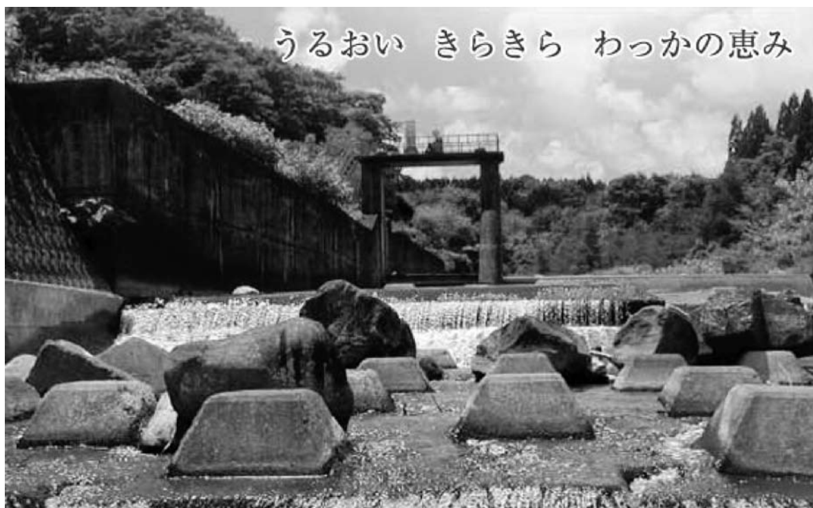
【改修予定の夏油頭首工】
