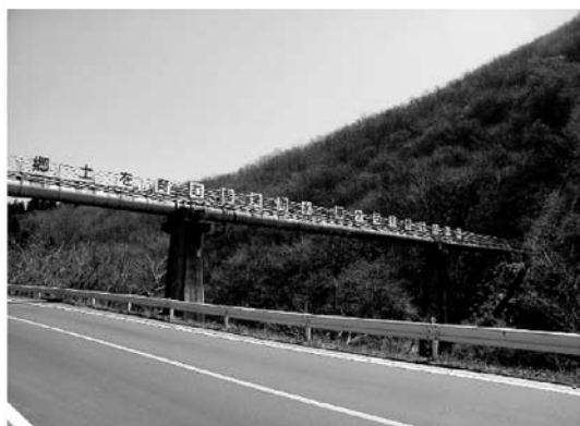
改修予定の猿ヶ石川サイホン
