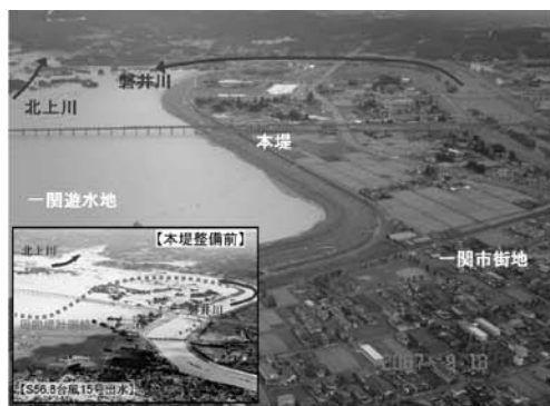
市街地を防御した一関遊水地本堤 (平成19年9月18日出水 岩手県一関市)
