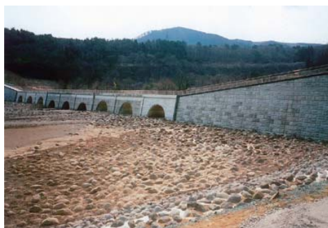
【完成した大暗渠堰堤】
