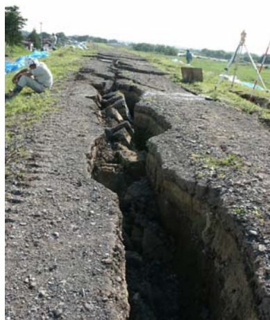
【被災後の鳴瀬川堤防】
