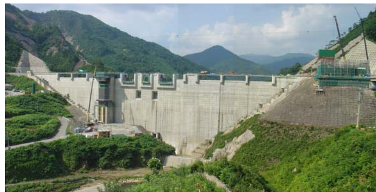
ダム本体コンクリート打設完了後の横川ダム （上流からダムサイトを望む：平成18年8月撮影）
