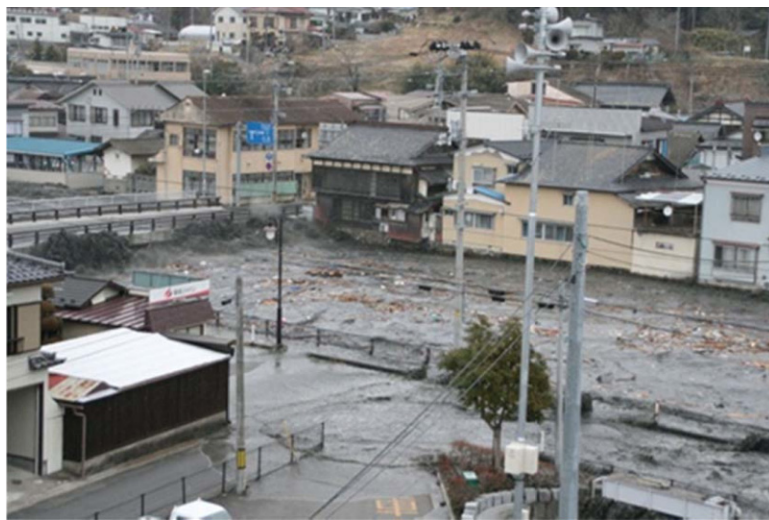
南三陸町役場防災対策庁舎屋上から北東方向を撮影。津波が押し寄せ八幡川が氾濫
