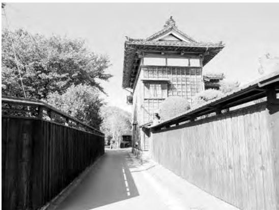
町屋の外観再生プロジェクトによる黒塀整備
