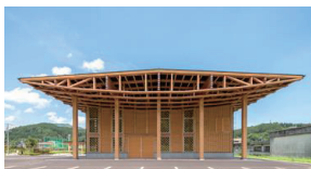
住田町役場新庁舎の外観と交流スペース
