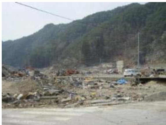
被災後の島越周辺の様子。
