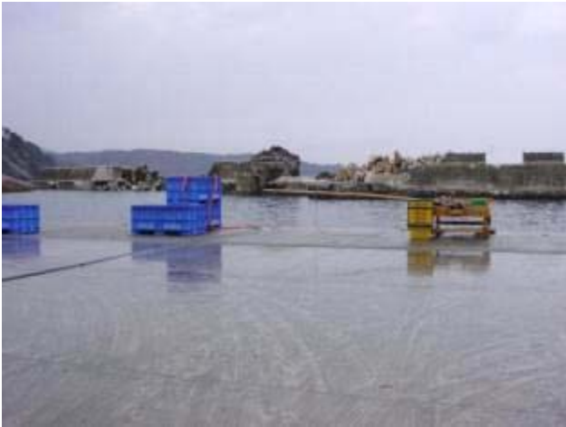
漁港全体が沈下し、かさ上げして新しくなった。
