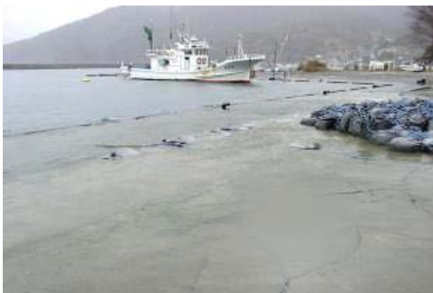
崎浜漁港 地盤沈下し、波が漁港に打ち寄せ、浸水している。
