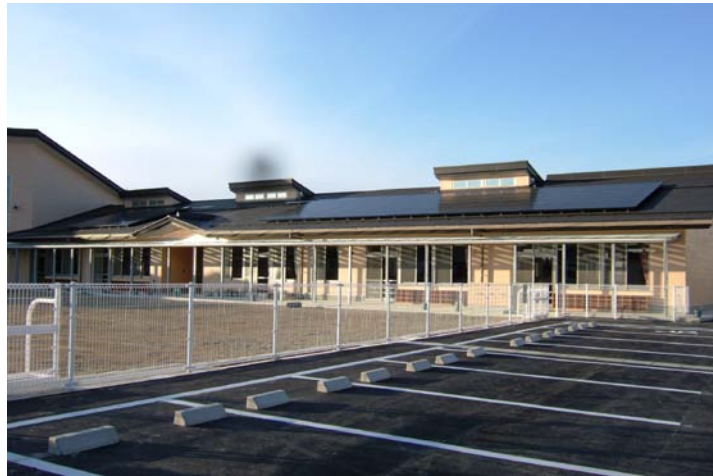
建物外観・発電装置
