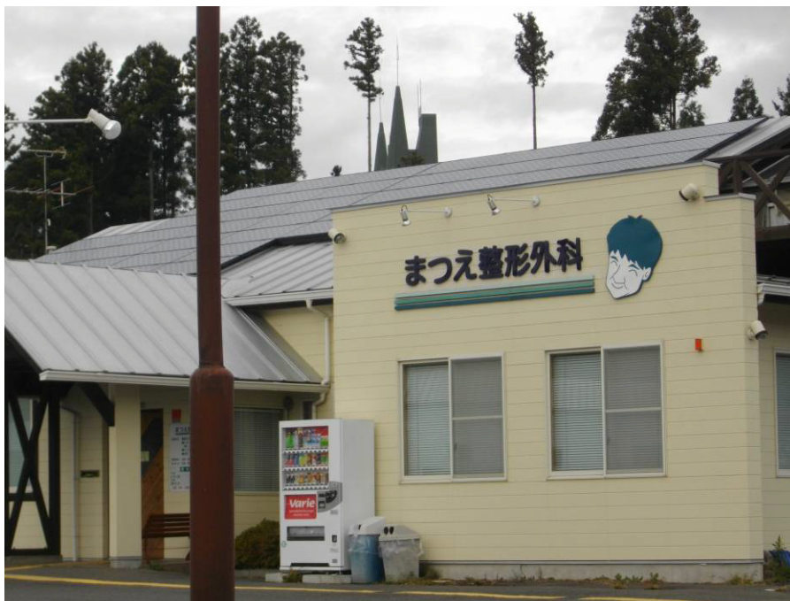
建物外観・発電装置
