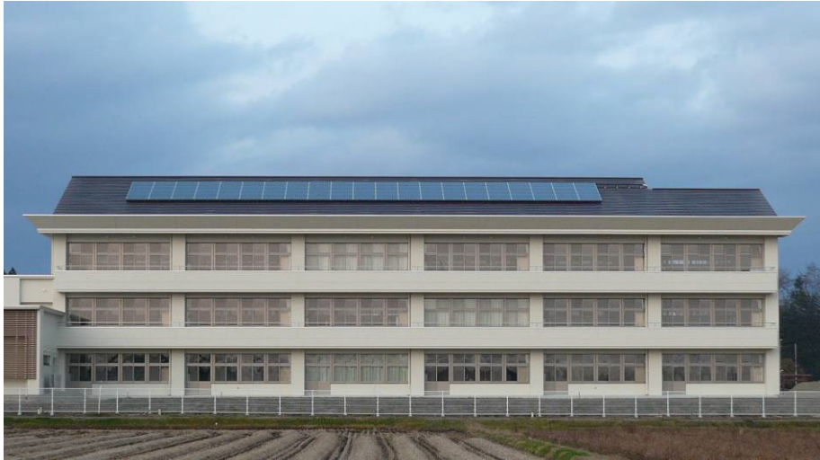
建物外観・発電装置
