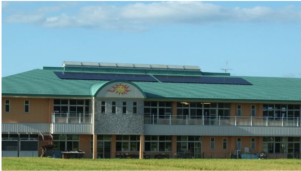
建物外観・発電装置
