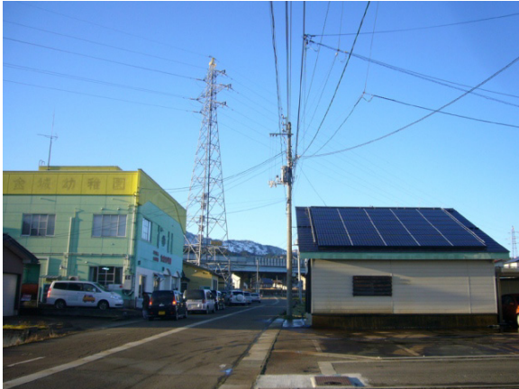
建物外観・発電装置
