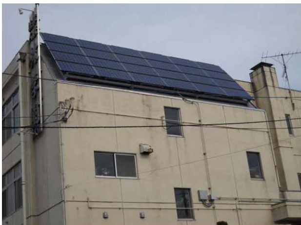
建物外観・発電装置
