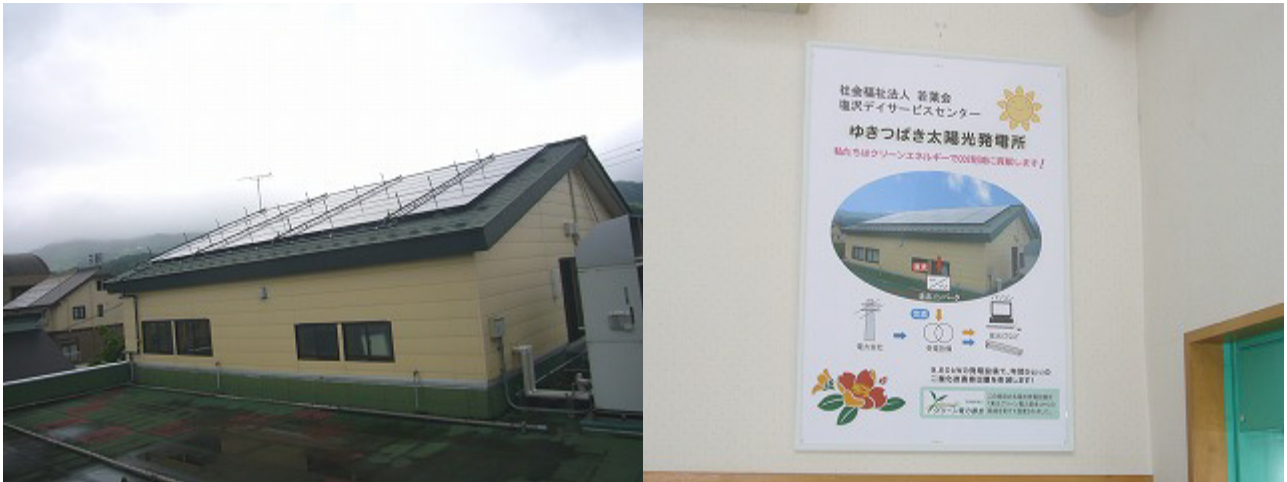
建物外観(発電装置) および 表示板
