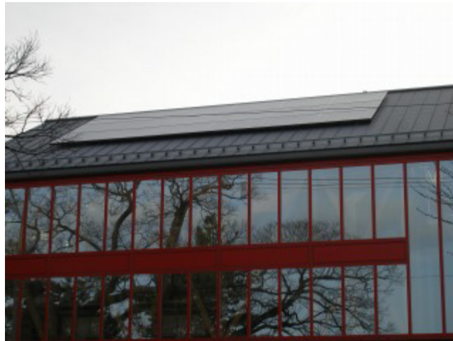
建物外観および発電設備
