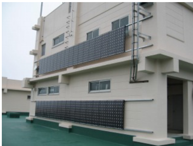
建物外観および発電装置
