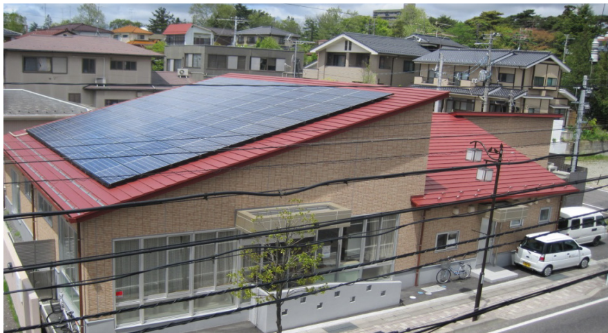
建物外観および発電設備
