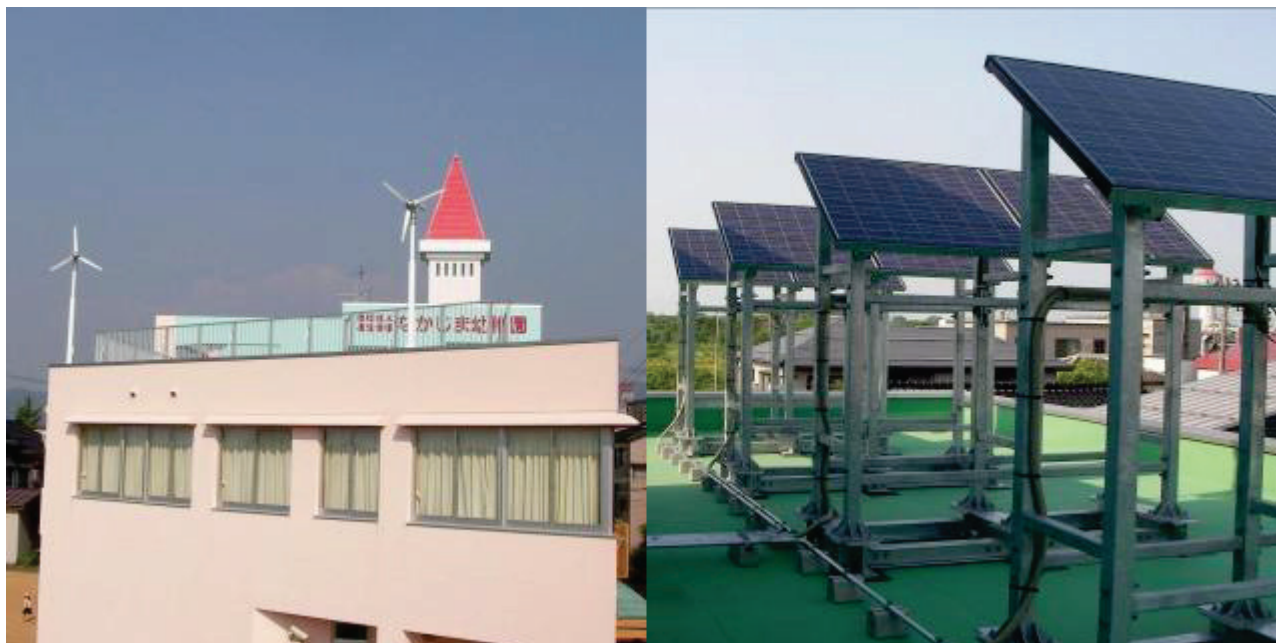
建物外観および発電装置
