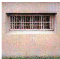
↑温度差によって自動開閉するオート床下土間換気
